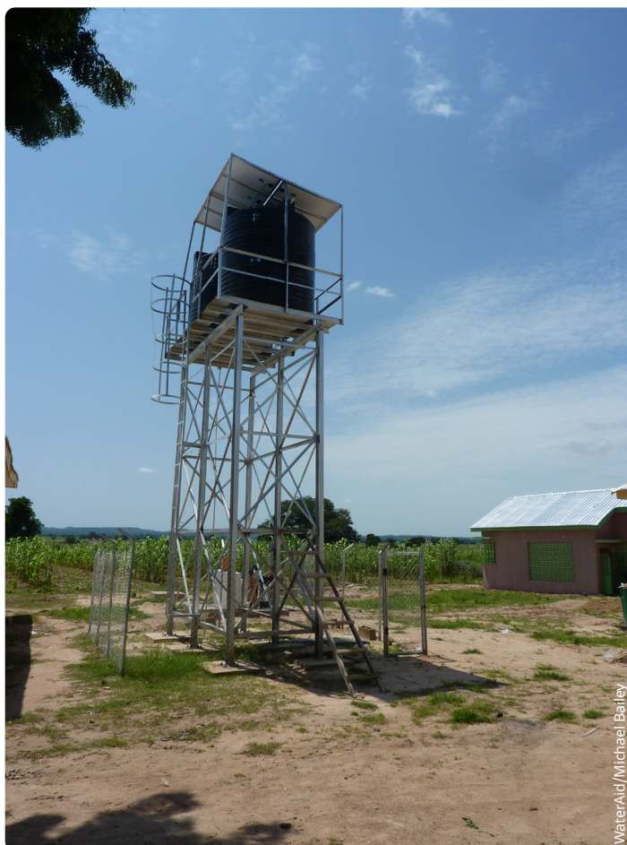
▲ Une tour de stockage d'eau avec des panneaux solaires pour alimenter la pompe d'extraction, dans le quartier de Kafin Iya, dans la zone de gouvernement local de Kirfi, État de Bauchi, au Nigeria, en septembre 2019.
