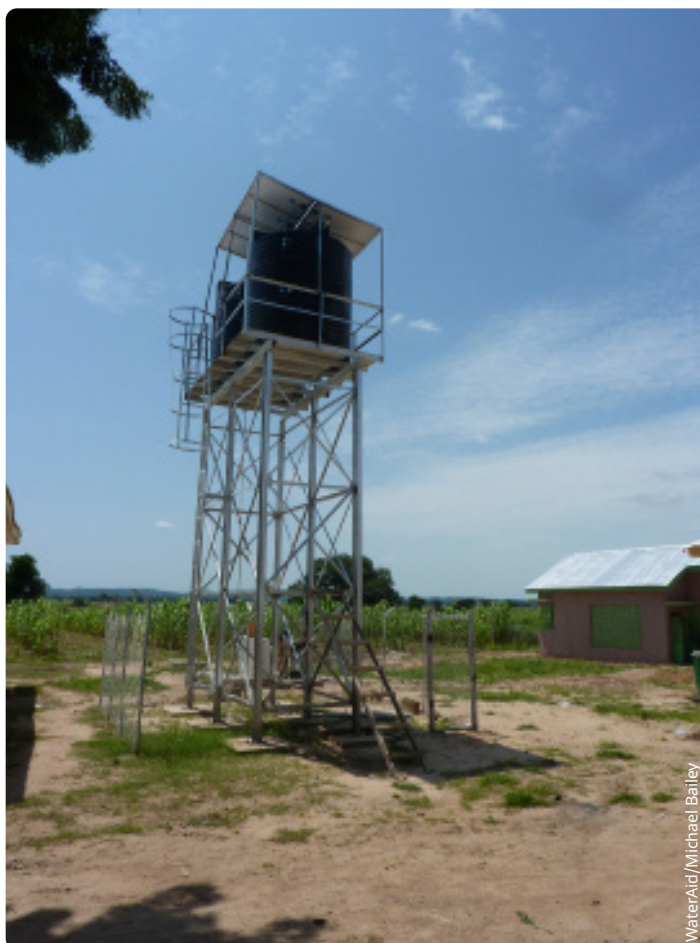
▲ Torre de armazenamento de água com painéis solares para bomba de extração de energia, em Kafin Iya ward, área do governo local de Kirfi, estado de Bauchi, Nigéria, Setembro de 2019.
