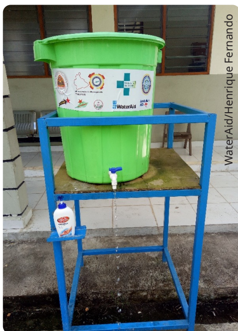
Figura 9- Facilidade fase liman ho tipu balde-torneira hanesan ida ne'e iha postu saúde Dotik iha sae makaas (uza tebes) durante COVID-19 maibé sasan sira ne'e reativamente uza iha tempu badak molok prezisa atu troka, ne'ebé aumenta tan kustu significante ba reabilitasaun durante tempu tomak.
